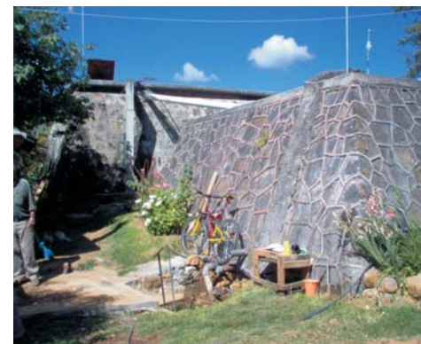
71. Tanque de mampostería superficial.
