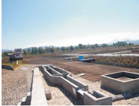
22, 23 y 24. Humedal de tratamiento de aguas residuales en Santa Fe de la Laguna.
