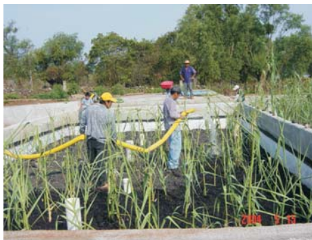
19, 20 y 21. Humedal de tratamiento de aguas residuales en Cucuchucho.
