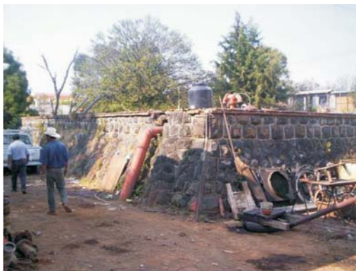
69. Tanque de regularización.
