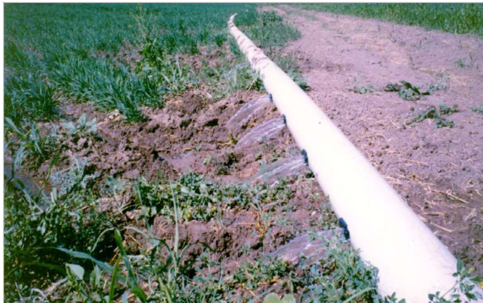
Figura 9. Sistema de riego de baja presión con tubería de compuertas, en el riego por surcos
