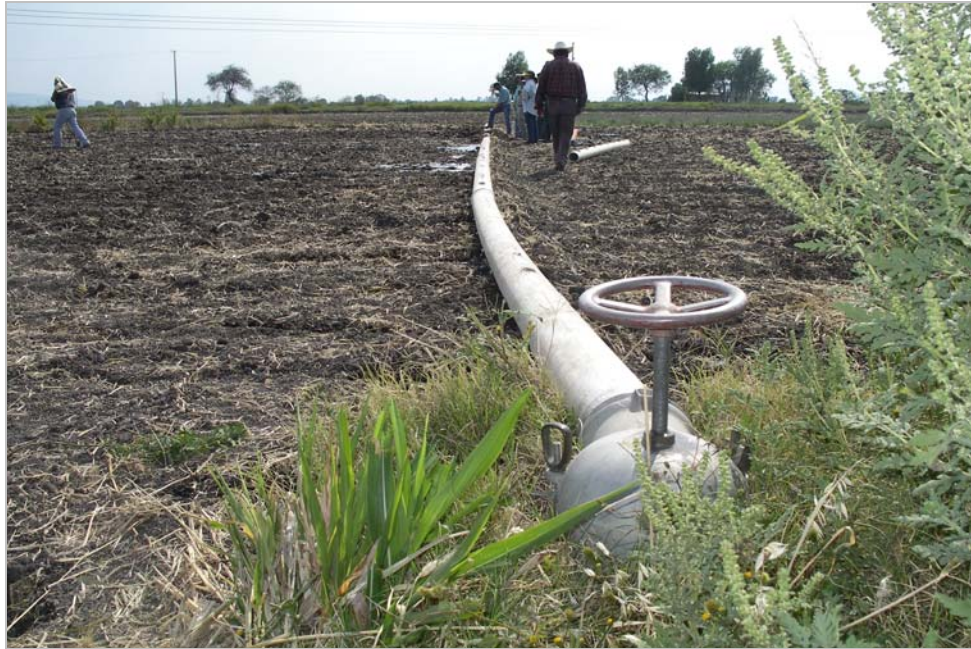
Figura 8. Hidrante y tubería con compuertas en la aplicación del riego
