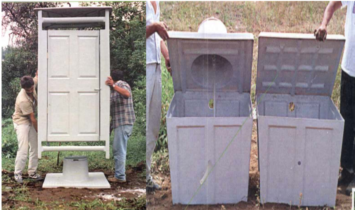
Figura 5. Letrina de doble cámara
