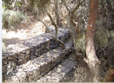
Represa de Gavión
