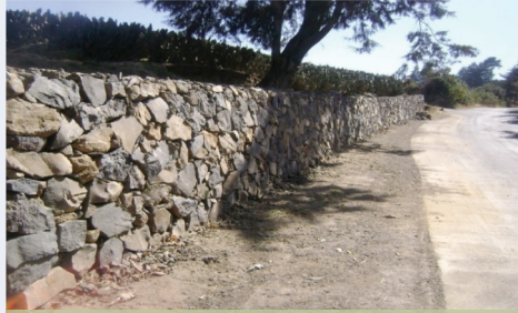
Muro de Piedra Acomodada
