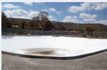
Hoya de captación
