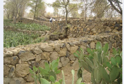
Muro de Piedra Acomodada
