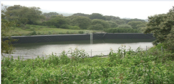
Hoya de captación
