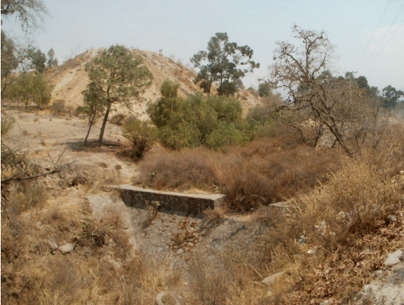
AZOLVE POR ARRASTRE DE MATERIAL DE MINAS, EJIDO DE SAN FRANCISCO ACUAUTLA, IXTAPALUCA.
