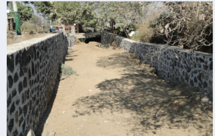
Muro de Contención
