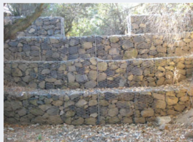
Muro de Contención
