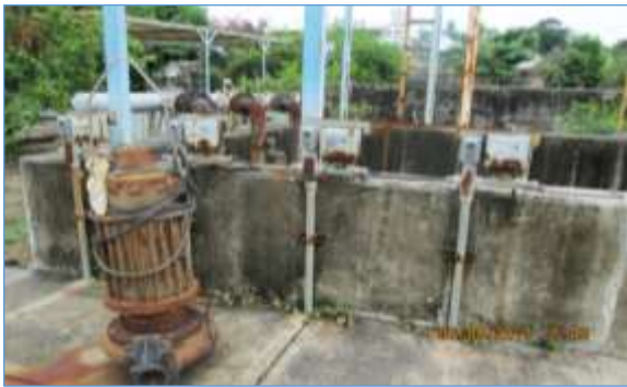
Situación actual de la Planta de Tratamiento de Aguas Residuales.
