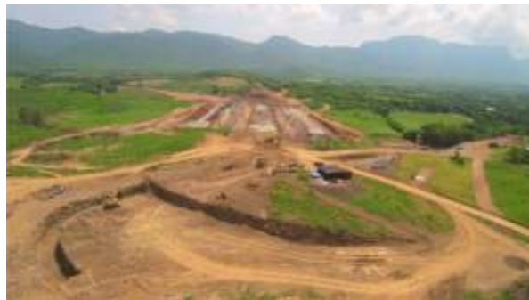
Desarrollo de los trabajos en la presa "El Chihuero".
