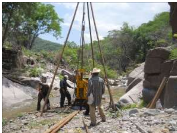
Sondeos geológicos sobre el eje de la cortina. Proyecto P. A. El Sandoval.
