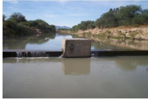
Foto 2.- El cruce del sifón a través del cauce forma un embalse que llega hasta cerca de Las Cuarteronas.
