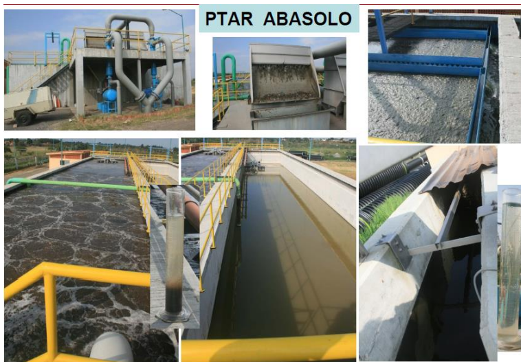
Figura 2.4 Planta de Tratamiento de Aguas Residuales del Municipio de Abasolo
