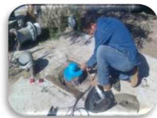
Figura 39. Instalación de tapas para pozos de monitoreo
