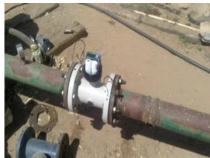
Figura 44. Reemplazo de baterías
