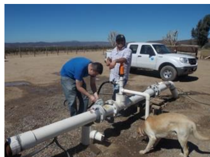
Figura 45. Instalación de medidores
