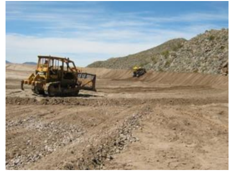
Figura 4. Obras de encauzamiento del arroyo el Carrizo.
