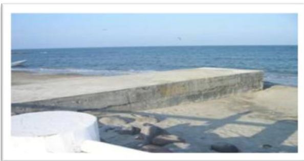
Descarga pluvial (colector colón), en temporada de lluvias las demasías se vierten a la playa a través de una compuerta.
