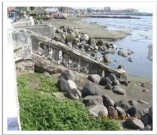
Construcción de rampas para vehículos de servicios, escaleras y accesos a discapacitados.
