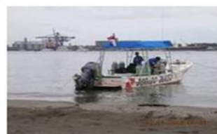
Instalación de pequeños muelles para embarcaciones ligeras.
