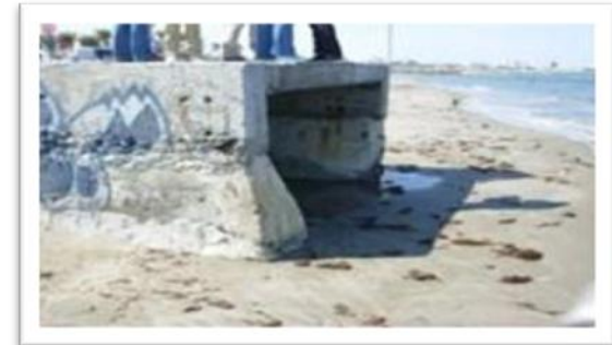
Descarga pluvial (colector colón), en temporada de lluvias las demasías se vierten a la playa a través de una compuerta.
