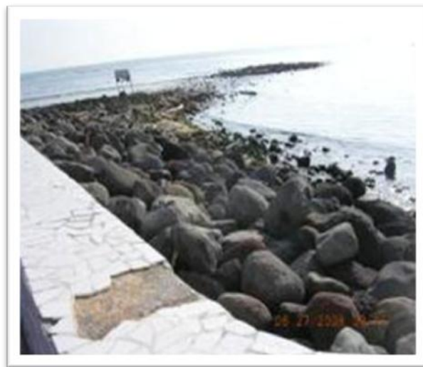
Revisión periódica de muros y muretes
