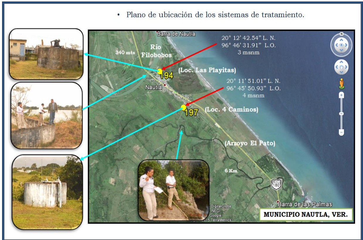
Figura 21. Vista panorámica donde se ubican los Cárcamos de Bombeo y que vierten sus desechos en los ríos en la cabecera municipal de Nautla, Ver.
