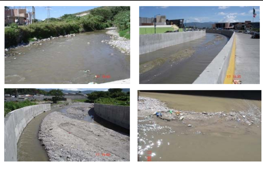
11 KMS DE CAUCE DEL RÍO
