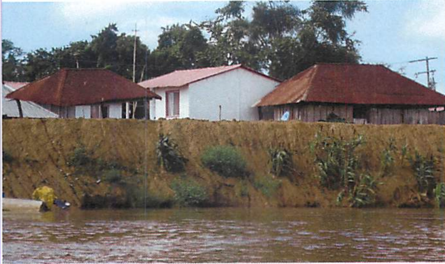
Figura 39. Muro de contención para salvaguardar asentamientos en zonas de riesgo.
