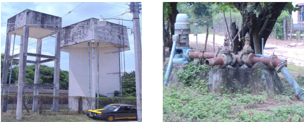
Figura 12. Sistema de abastecimiento de Agua obsoleto
